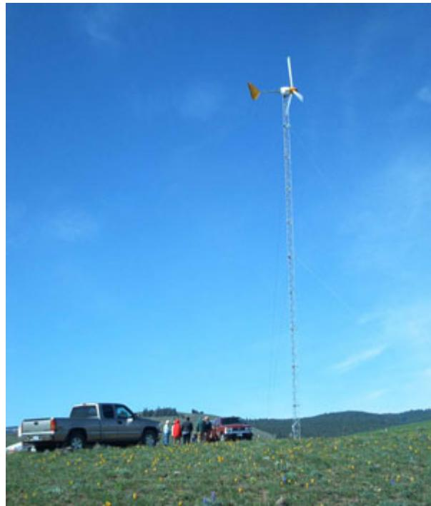
Turbinele Bergey pot functiona in siguranta chiar in lipsa acestor consumatori divertori, in orice conditii pana la viteza maxima de proiectare a vantului ( 198 km/h ).
